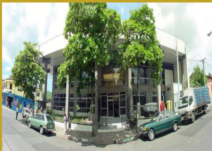
ADMINISTRACIÓN CENTRO JUDICIAL DE SAN VICENTE "DR. SARBELIO NAVARRETE" 2ª. Av. Nte. Y 5ª. Calle Oriente., Tel.: 2393-1172
